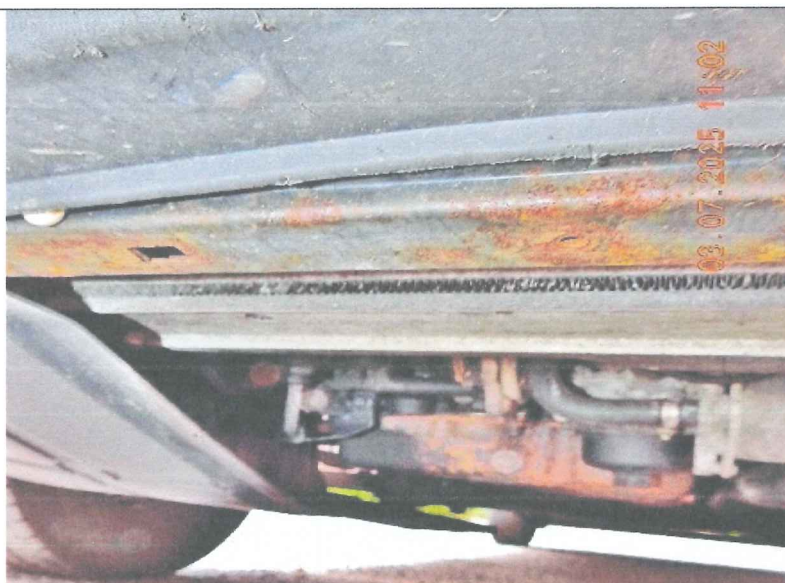
Belka wspornikowa przednia głęboko skorodowana. Miska olejowa głęboko skorodowana.
