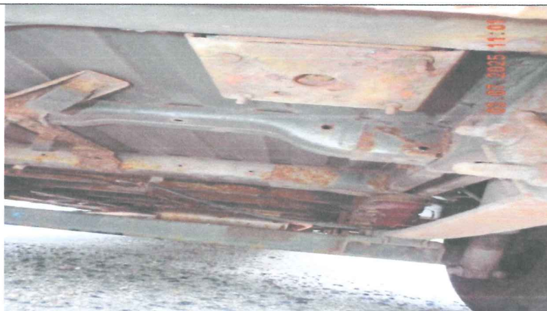
Podłużnice i wsporniki podłogi, głęboko skorodowane.
